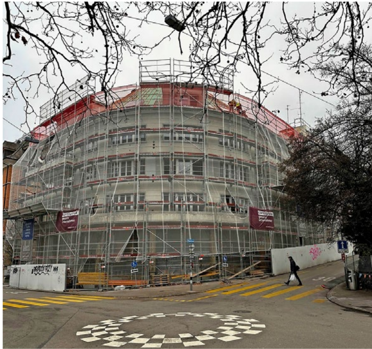
Die Liegenschaft Freiestrasse 12 / 14 in Zürich-Fluntern wird aktuell saniert. Das Lebensmittelgeschäft Russo musste ausziehen.
