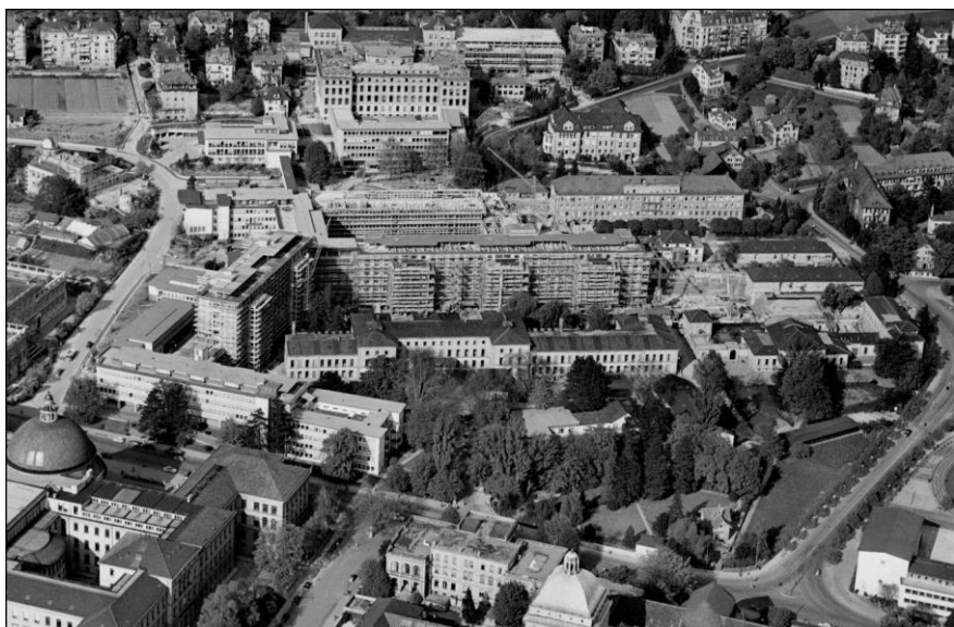
Luftaufnahme des alten Kantonsspital-Hauptgebäudes von 1840 (heute Spitalpark), umgeben von den neuen Bauten, um 1951 (Aufnahme von: R. Strub, Kantonale Denkmalpflege Zürich).
