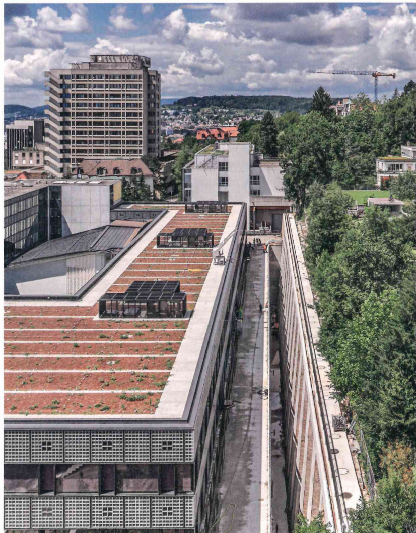
Siegerprojekt in der Kategorie «Infrastrukturbau»: Hangsicherungstragwerk für das neue Forschungs- und Laborgebäude GLC der ETH Zürich.
