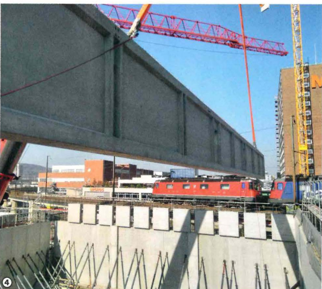
Impressionen von den Siegerprojekten: ① Bewehrungsarbeiten im Treppenhaus Ost des ehemaligen Felix Platter-Spitals; ② Schalungs- und Armierungsarbeiten für die 15 Bögen des Hangsicherungstragwerks beim GLC der ETH Zürich; ③ Holzkessel für den Holzwärmeverbund auf dem tuwag-Areal in Wädenswil; ④ Einhub eines vorgefertigten Betonträgers für die erste Etappe des ewz-Areals Herdern; ⑤ Einbau der textilen Erdwärmesonde von TTS Inova.
