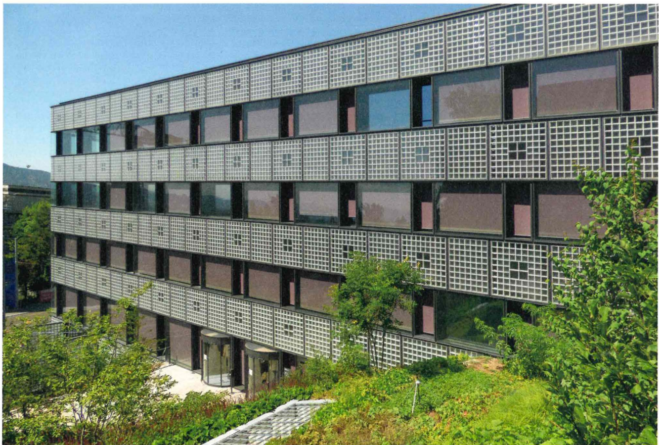
Die markante Doppelfassade des GLC. Im Bereich der zurückversetzten Lüftungsflügel ist die Fassade einschichtig.
