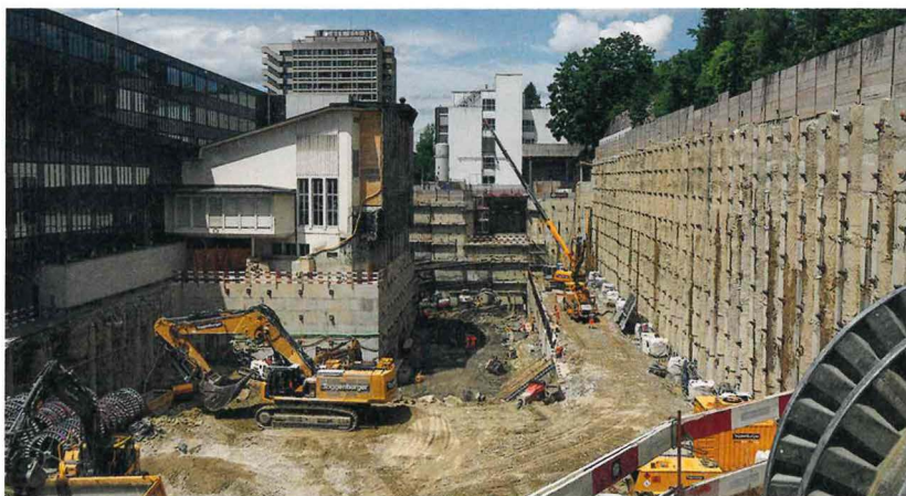
Die Baugrube mit ausgefachter Bohrpfehlwand und dem unterfangenen Paul-Scherrer-Hörsaal.
