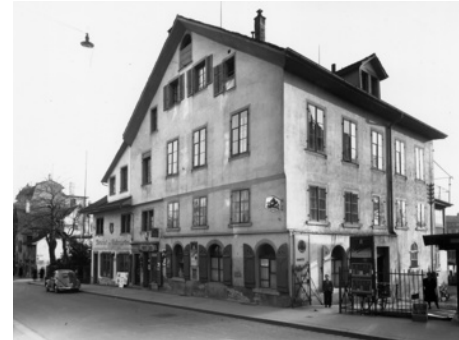
Legendärer Treffpunkt kurz vor dem Abriss 1956: Das Restaurant Plattengarten (Bild: BAZ_107008, Landolt-Arbenz)
