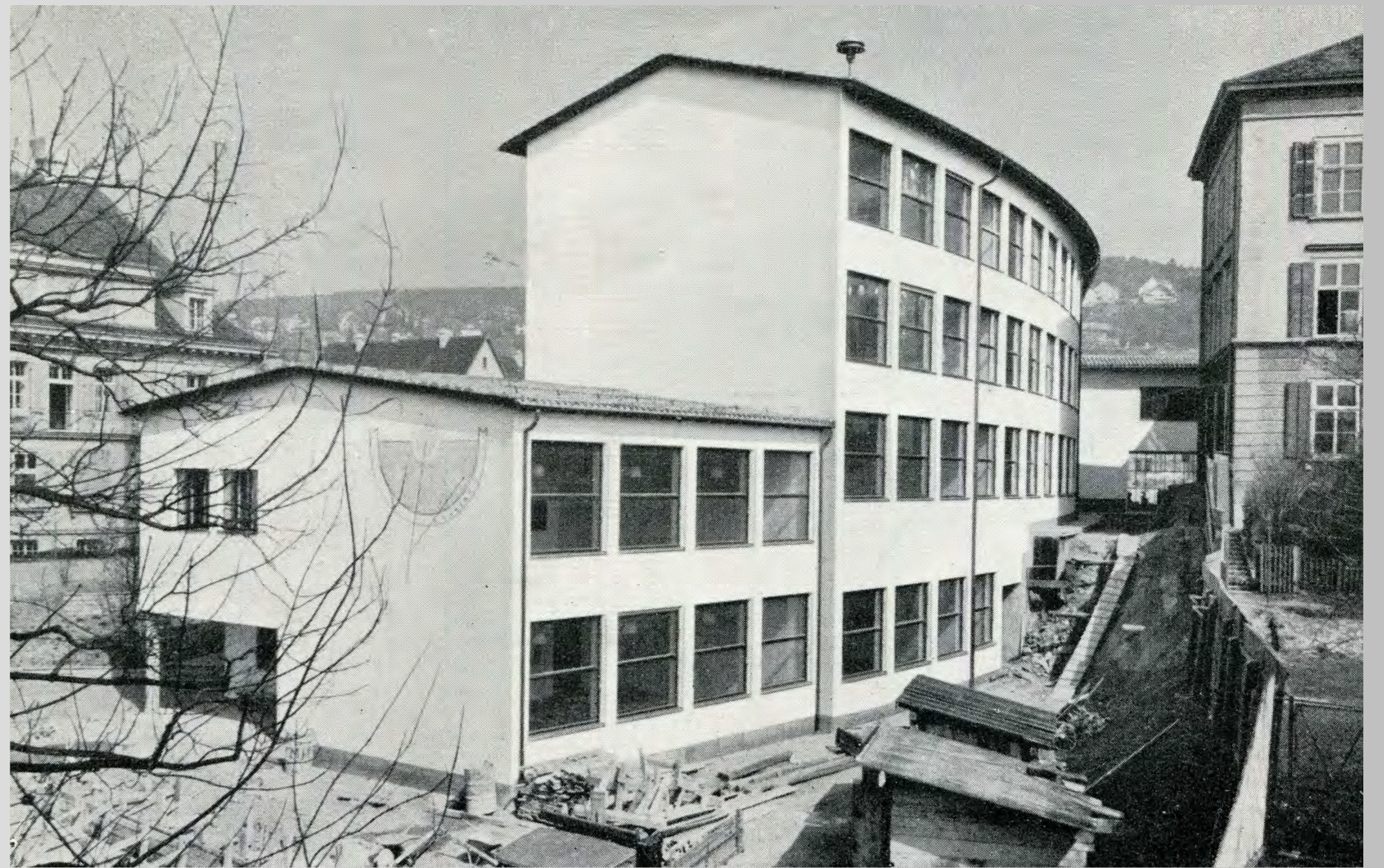
66 1939 Flunterns 4. Schulhaus im Bau, rechts das 3. Schulhaus vor dem Abriss. Festschrift 1942
