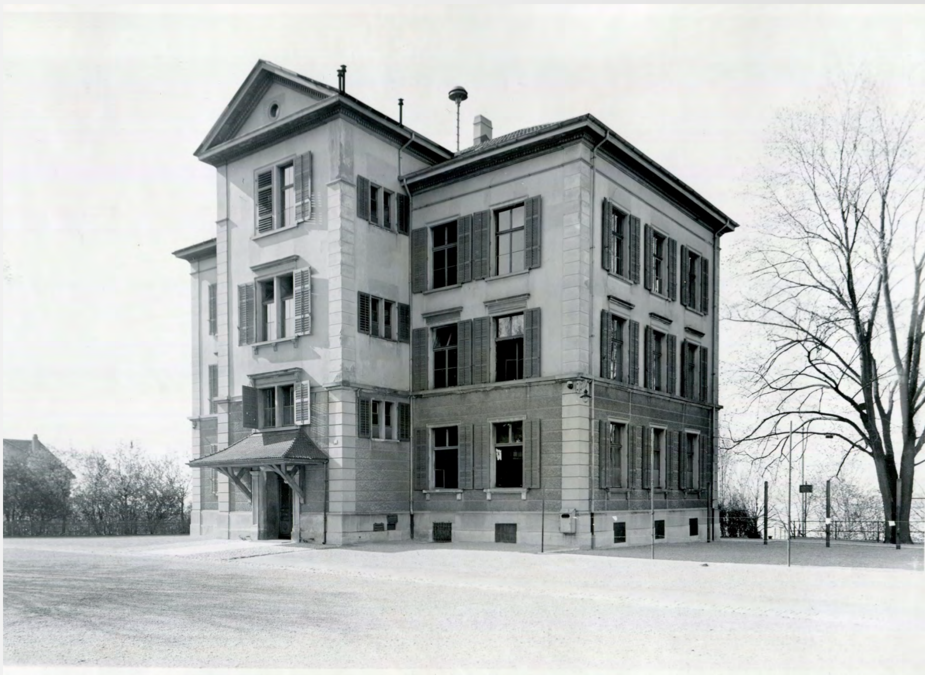
65 1940 Flunterns 3. Schulhaus. BAZ
