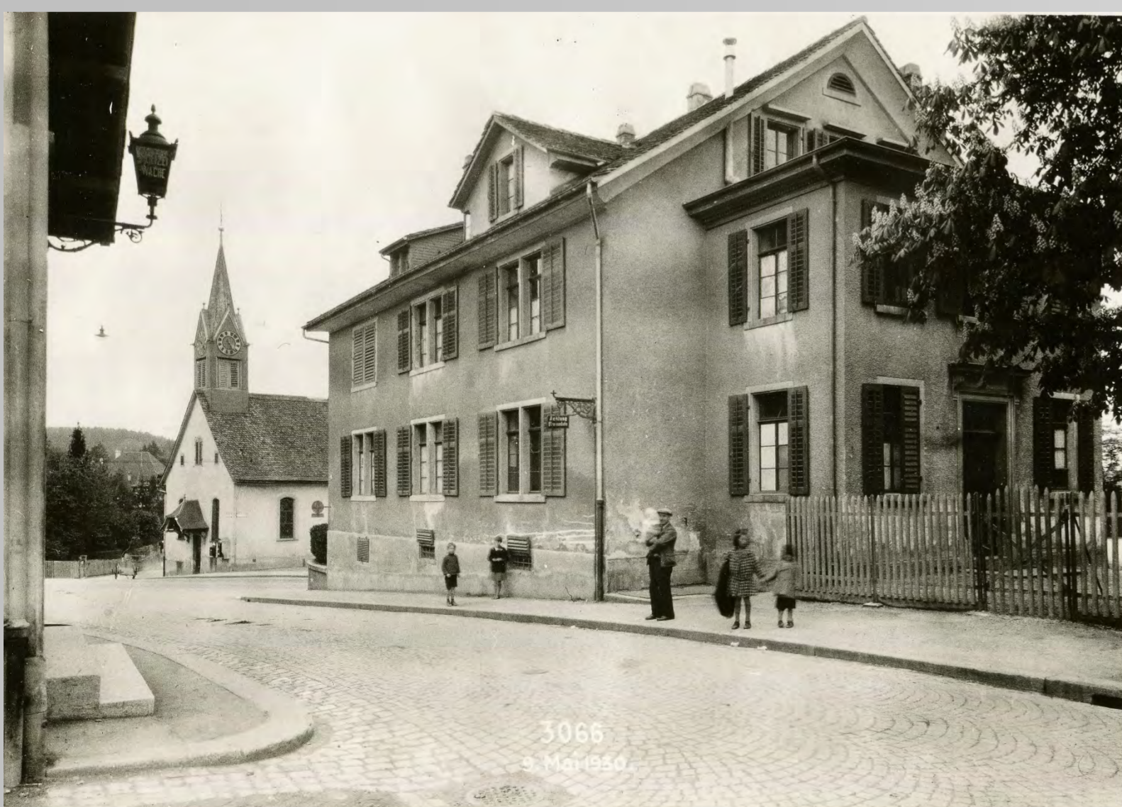
63 1940 Flunterns 2. Schulhaus. BAZ
